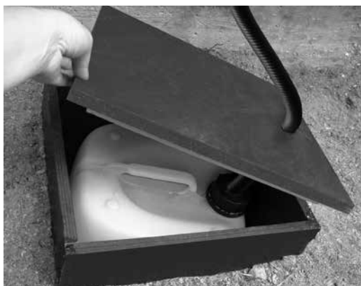
Rysunek 1 Zbiornik na ciecz odciekową
