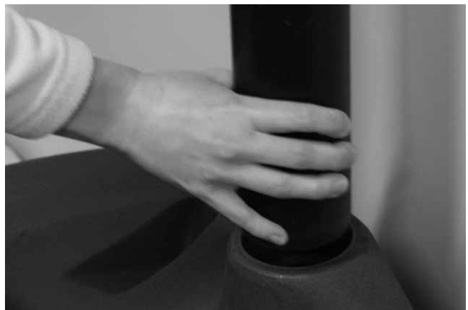
3. Abmontieren des Entlüftungsrohres
